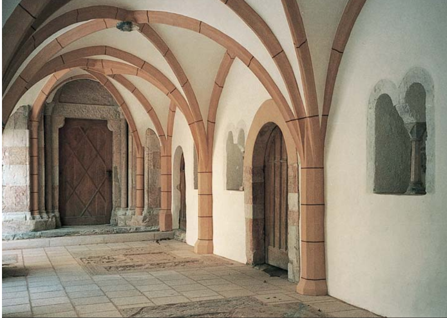
Rechts Eingang in den ehemaligen Kapitelsaal
