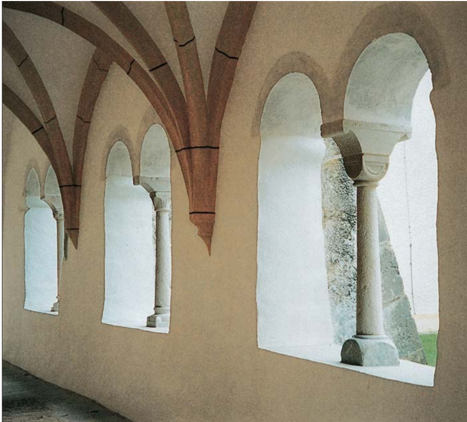
Arkadenöffnungen im Westteil des Kreuzganges
