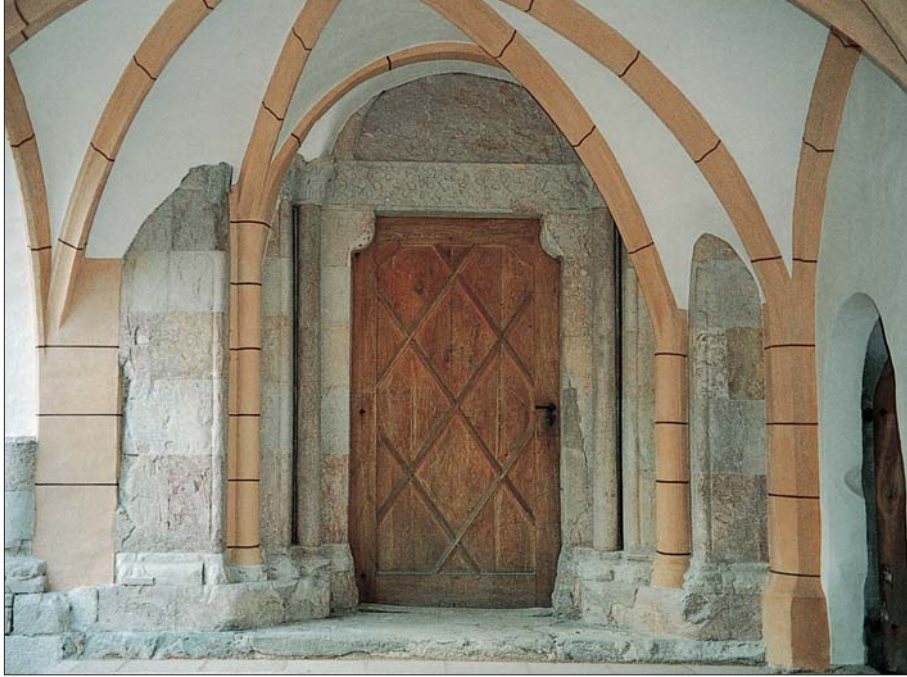
Romanisches Portal zur Gruft, in der Gotik asymmetrisch überbaut
